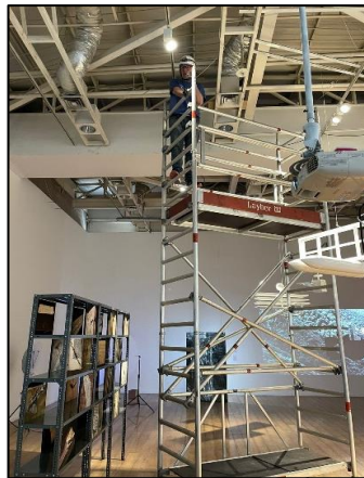
Cambio de luminaria, salón de exposiciones temporales.
