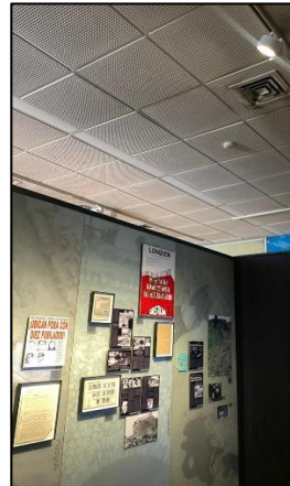
Cambio de luminaria Zona Hallazgos.
